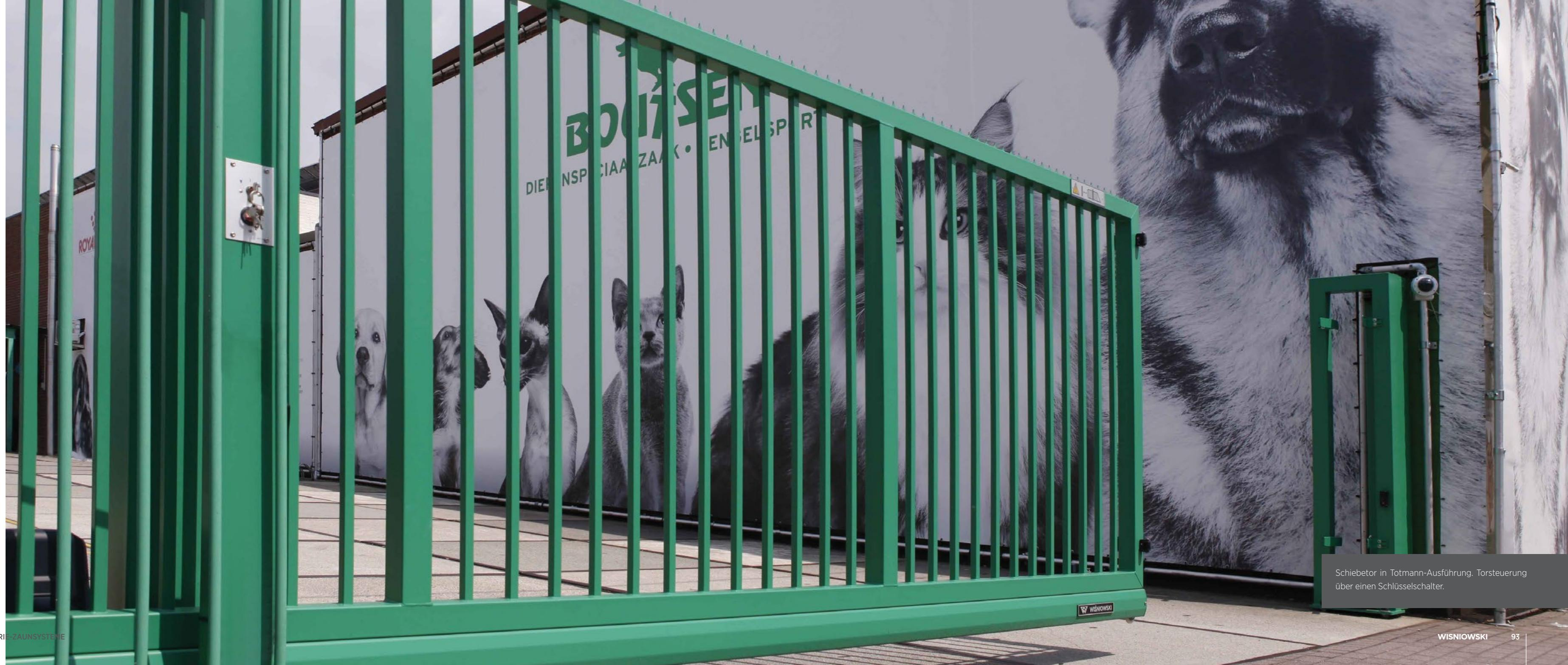
Schiebetor in Totmann-Ausführung. Torsteuerung über einen Schlüsselschalter.
